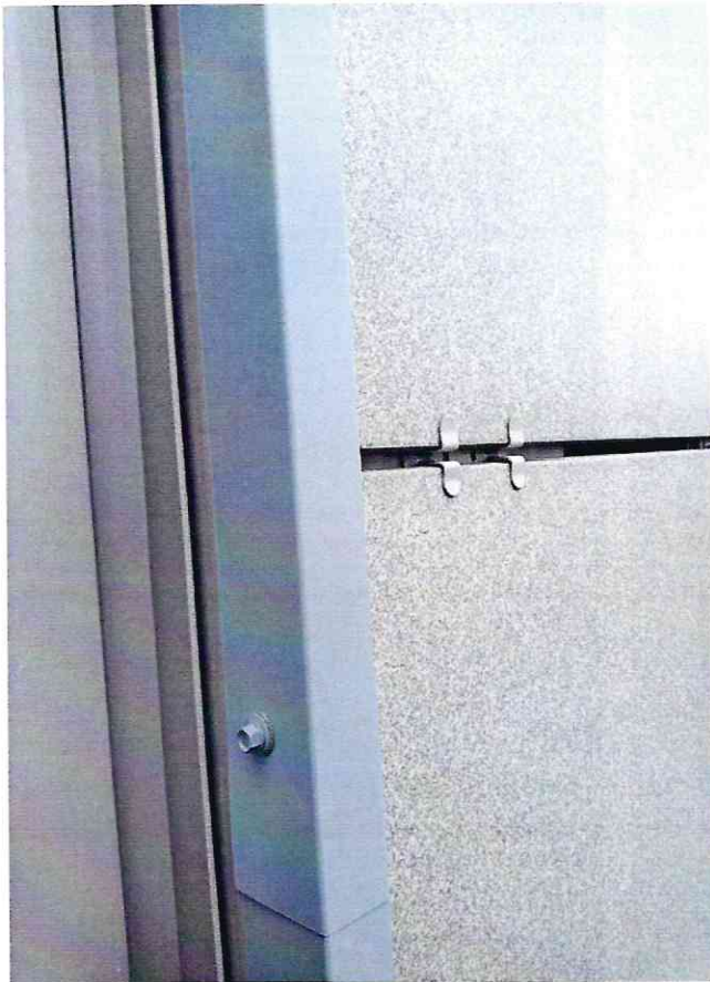
Пример монтажа прижимных планок
